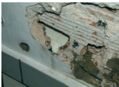
Fot. SILTEN K można stosować nawet w otworach wierzonych poziomo
