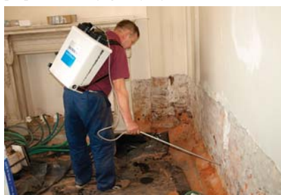
Fot. 2. Wypełnianie otworów w murze preparatem SILTEN K
